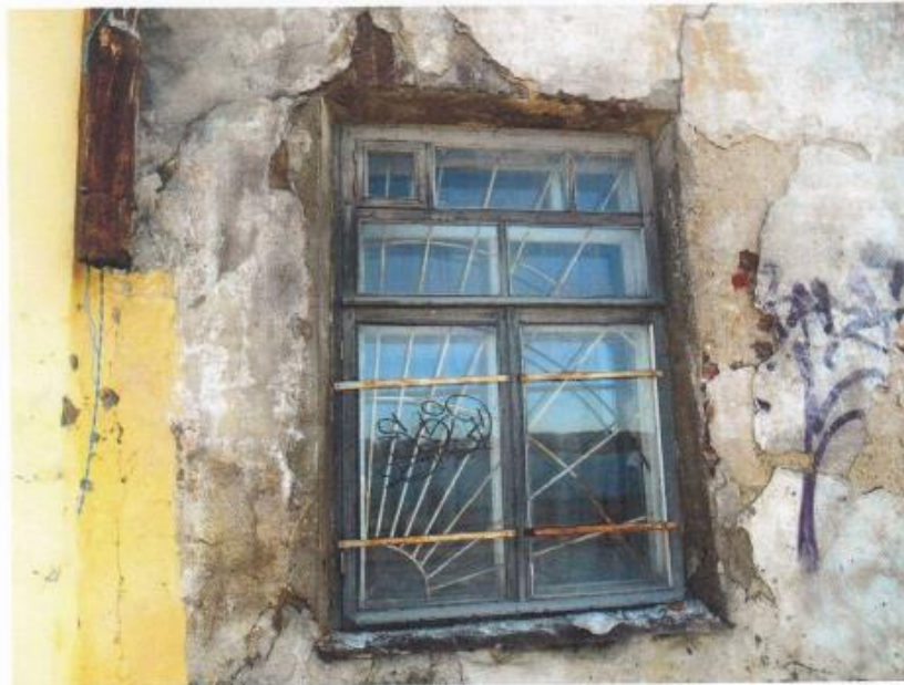
Фрагмент оконного заполнения
