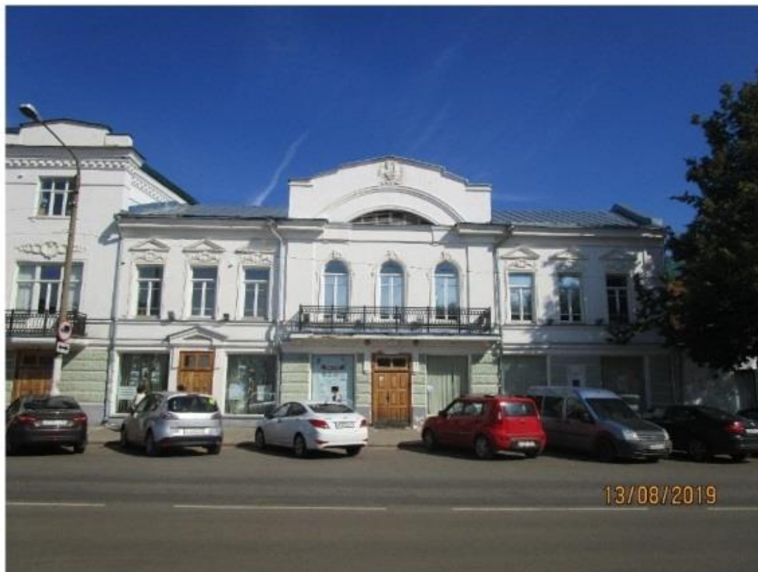
Фотографическое изображение объекта культурного наследия регионального значения «Здание кинотеатра С.К. Бархатова, 1913 г.», расположенный по адресу: Костромская область, г. Кострома, ул. Советская, 2/1
